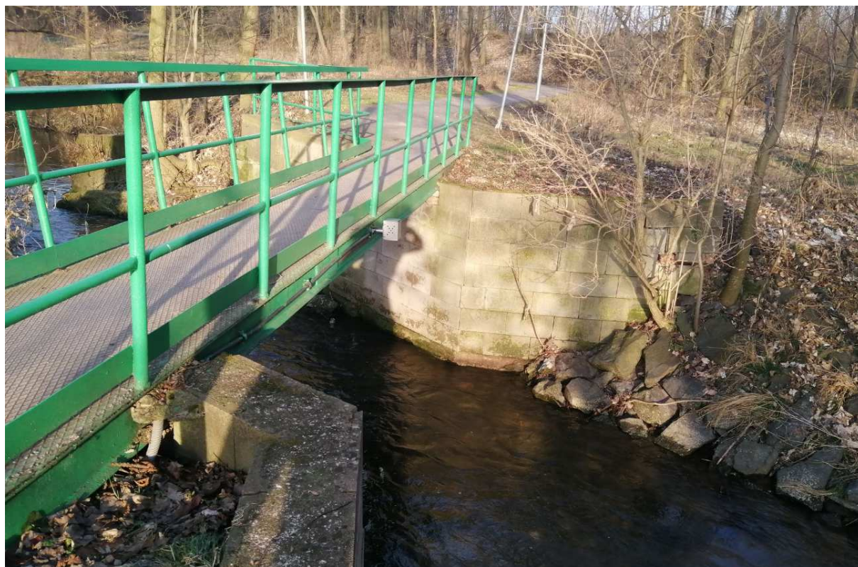
Obr. 2 – Umístění automatického vodočetného zařízení na nosné konstrukci lávky
